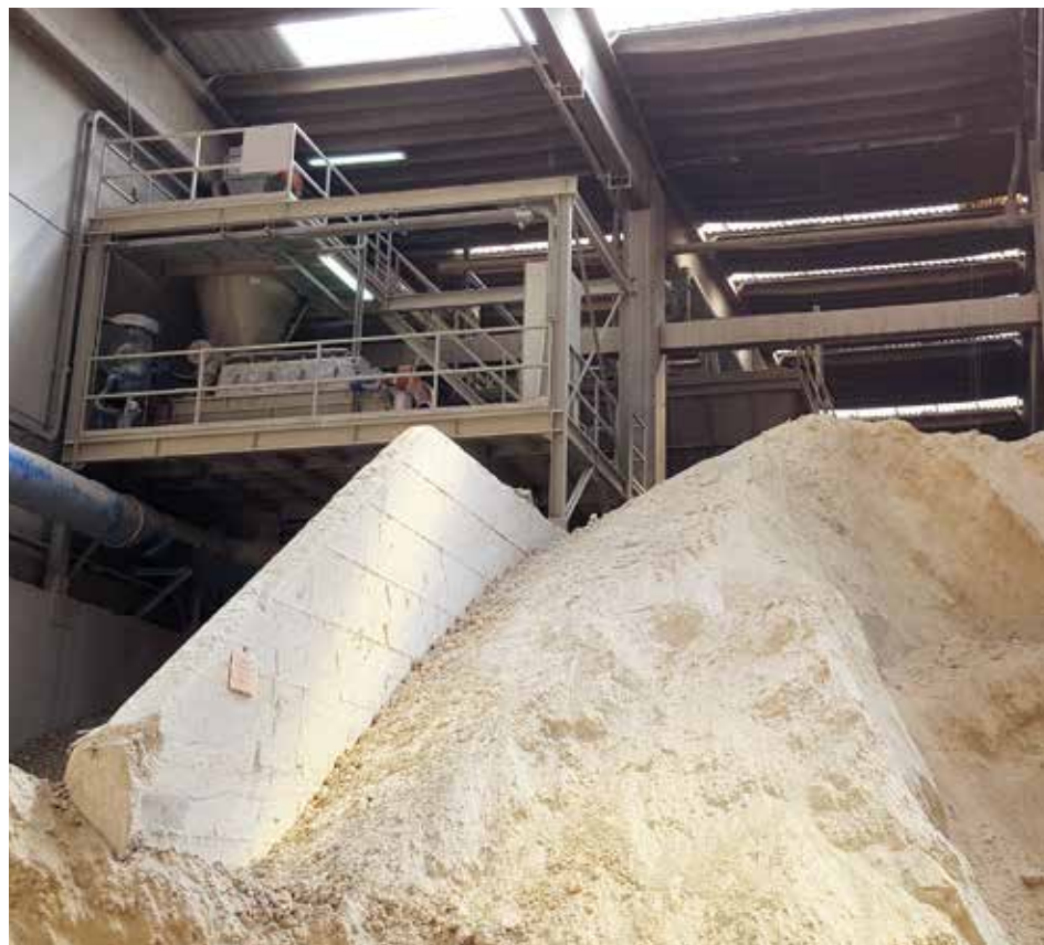
Linea umidificazione e recupero polveri nel processo Wetting line and powder recovery in the process
